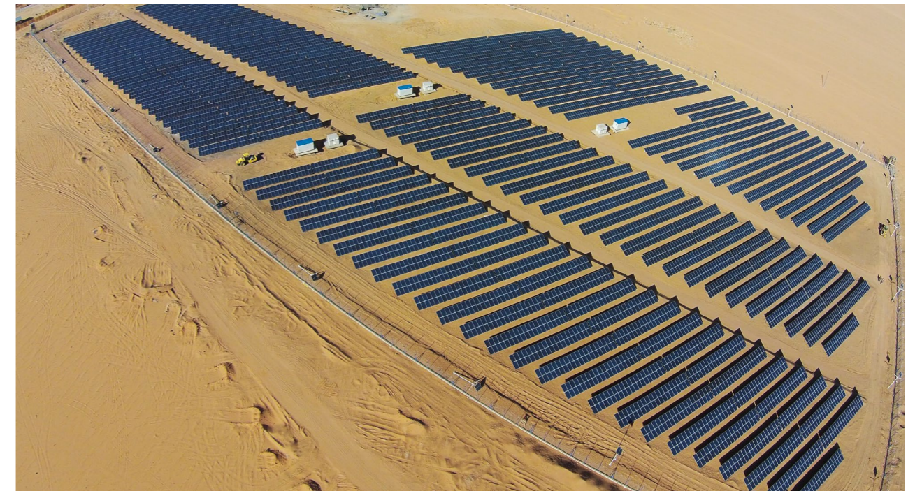
阿尔及利亚 25MW 光伏电站项目利用丰富的太阳能资源优势、实现光伏发电 Algeria 25MW PV Power Project takes advantage of abundant solar resources to realize PV power generation.
